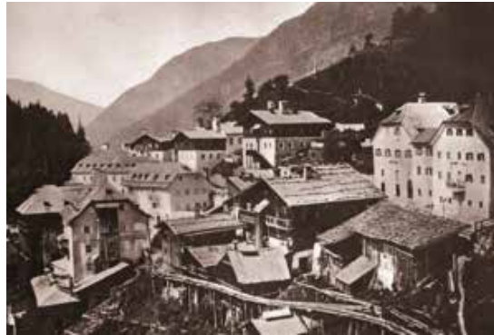
In hölzernen Thermalwasserleitungen wurde das Thermalwasser um ca. 1865 an den Bestimmungsort geleitet.
